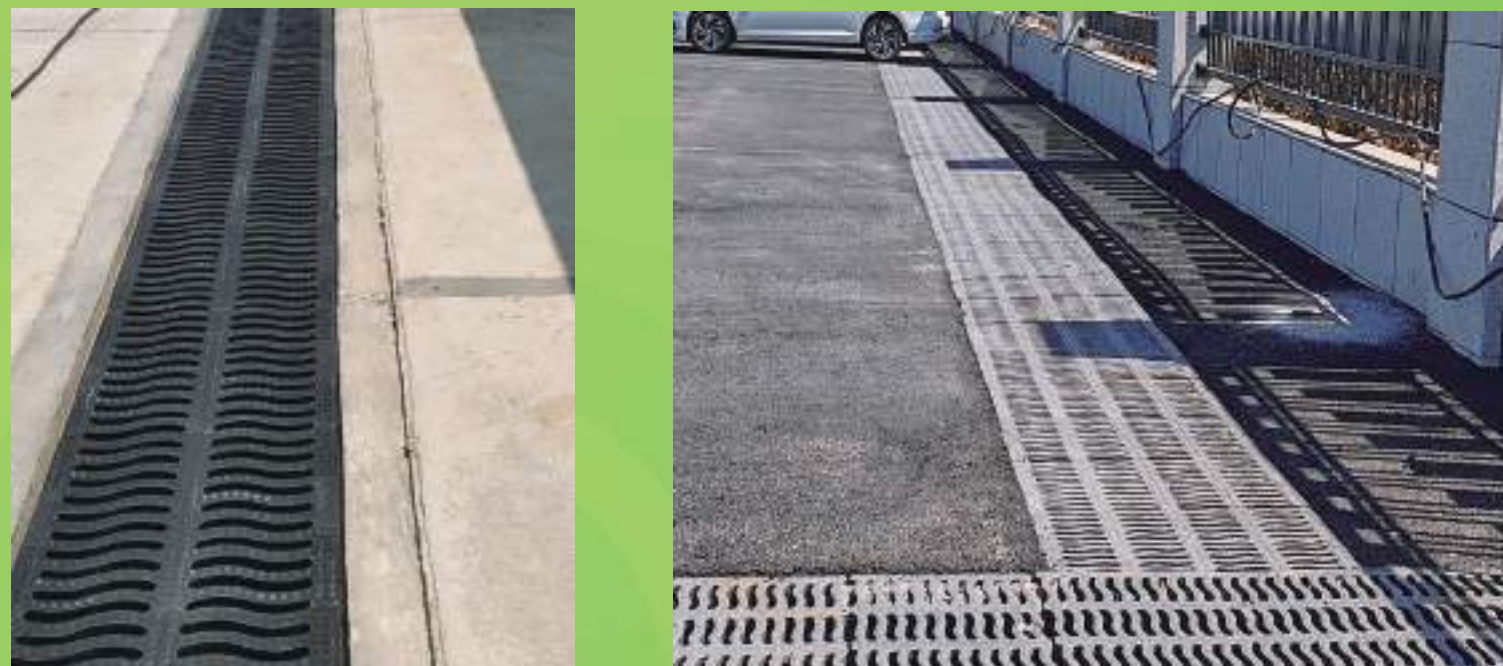
現場施工及完成圖
